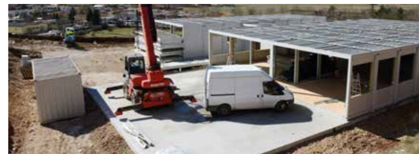
Il cantiere dove sorge la scuola di Norcia.
