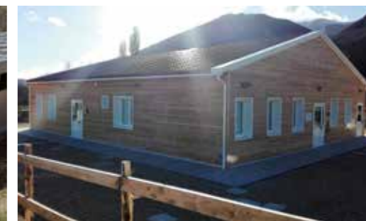
La scuola di Cittareale realizzata a novembre.
