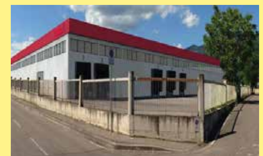
Il magazzino prima e dopo.
