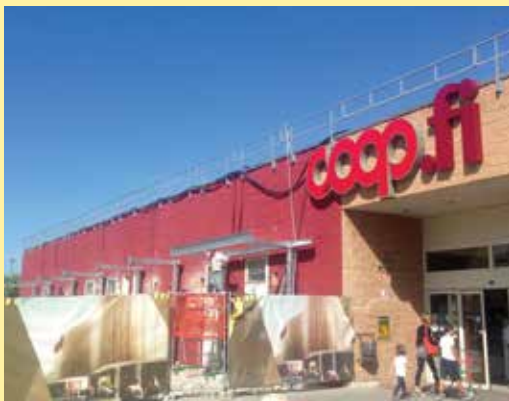
I lavori al negozio di Castelfiorentino
