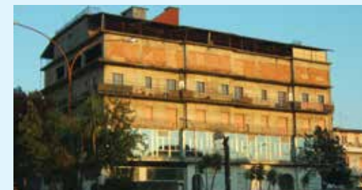
Il palazzo prima della ristrutturazione
